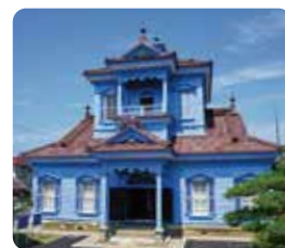
重要文化財 旧鶴岡警察署庁舎
