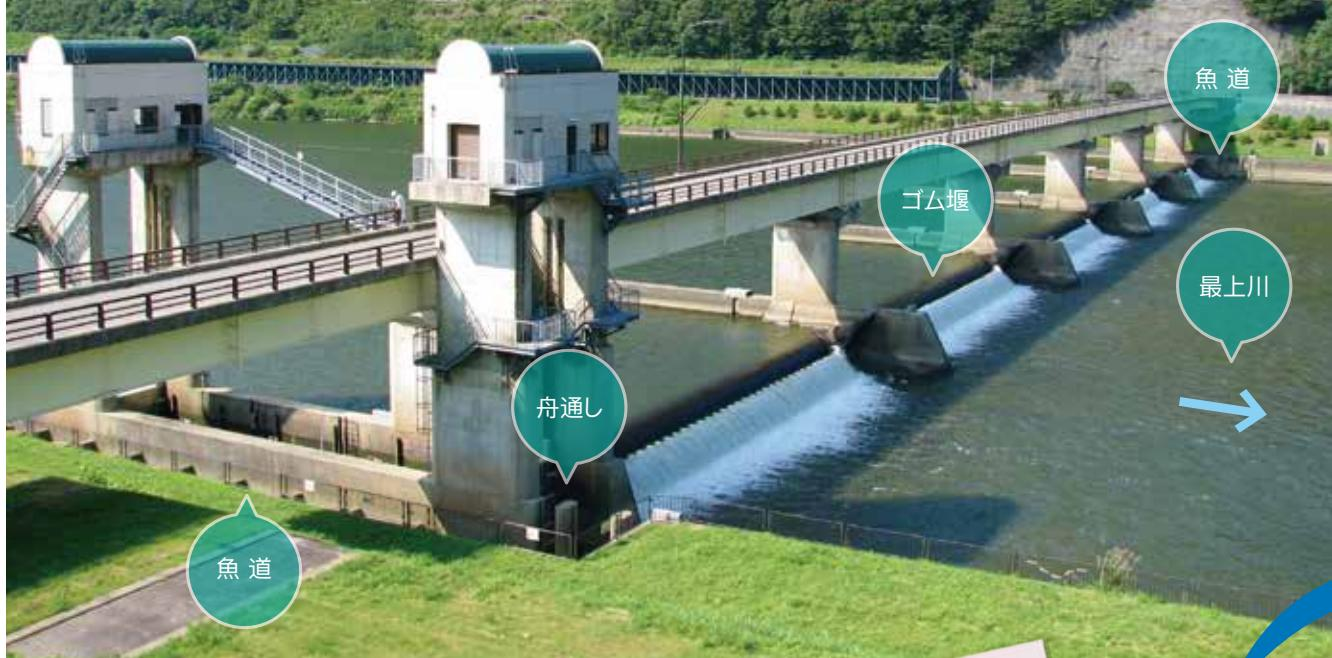
最上川を横断する日本最大級のゴム堰で全長209.5m。川の氾濫の予防と農業用水の安定的な取水確保を目的に整備され、現在では庄内平野の広大な田畠を潤す重要な堰として活躍しています。
